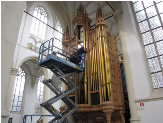
Vandaag zijn de pijpen van het zuidfront geplaatst
