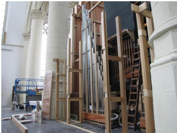
Het frame van het westfront wordt opgebouwd
