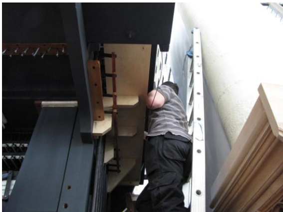
Jonathan installeert de bedrading t.b.v. de setter
