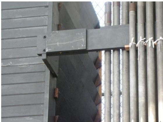
De jaloezieën van de zwelkast zijn geplaatst
