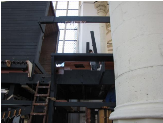
De eerste pijpen van het Great worden geplaatst
