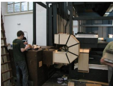
Nieuwe windkanalen op hun plaats
