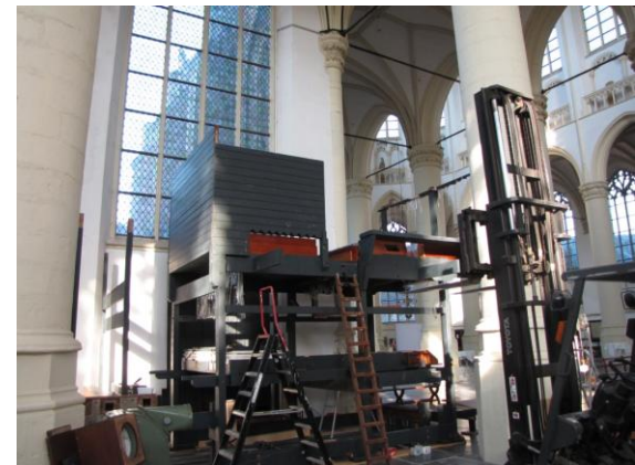
De zwelkast aan de achterzijde is nu ook in opbouw
