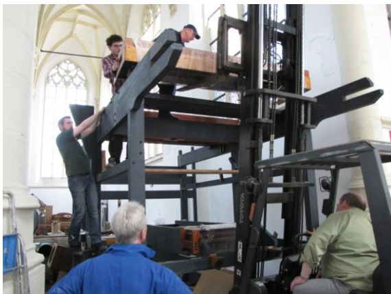
De eerste windladen worden op het frame gezet
