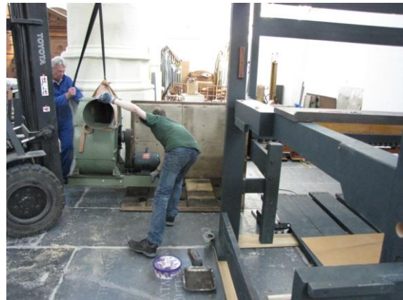
De windmotor wordt geplaatst, in een dempkast
