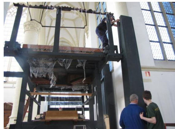
... wordt nu in het orgel geplaatst
