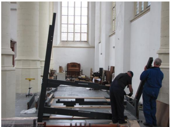
De opbouw van het frame begint
